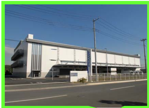
2007年12月稼動 アルフレッサ(株)神奈川物流センター
