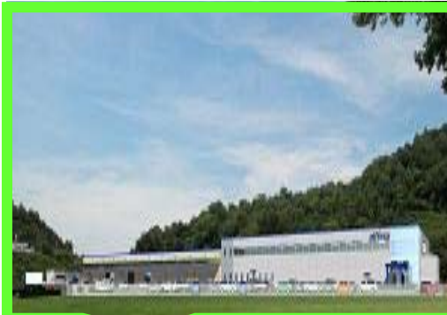
2008年7月稼動予定 四国アルフレッサ(株)四国地域の物流センター
